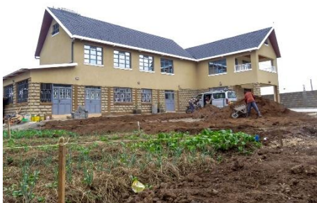
Endausbau beim Gian -Care -Center
